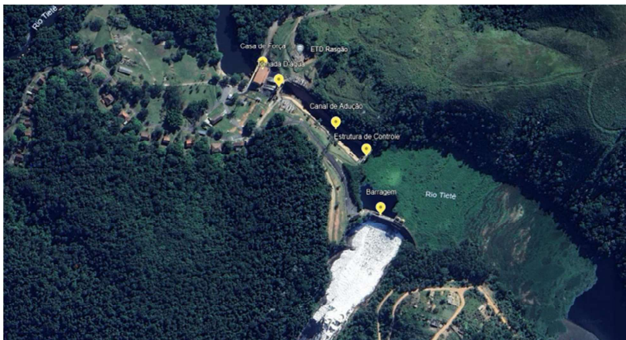
Figura 7 Identificação das Estruturas da EMAE.
