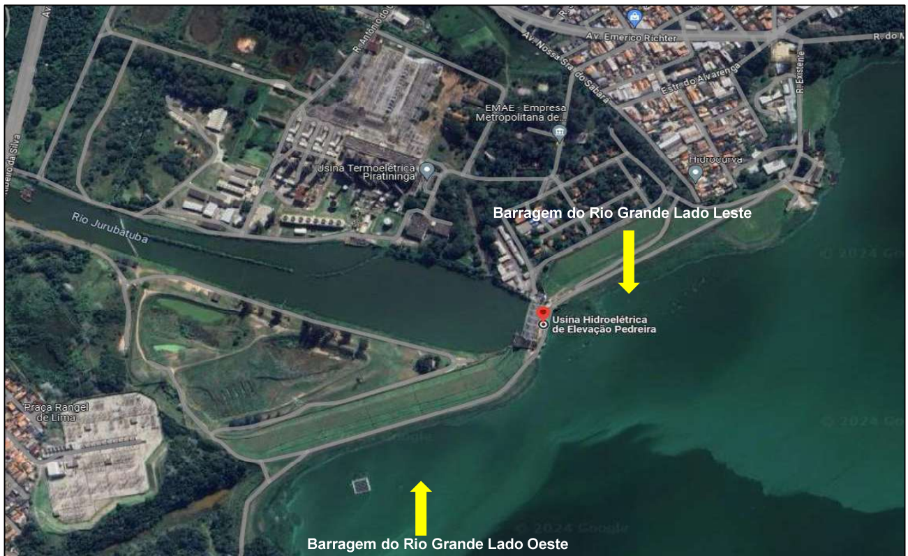
Figura 7 Identificação das estruturas da EMAE.
